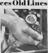
THIS MULTI-TUBING conduit holds twelve of the quarter-inch polyethylene-coated copper tubes. E CONDUTTO di multi-tubing ta contene doce tubo di cooper di un cuarto di pulg cubri polyethylene.
